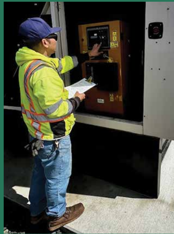
(Hình trái) Nhân viên vận hành thao tác với máy phát điện để đảm bảo dịch vụ không bị gián đoạn khi mất điện. (Hình trên) Nhân viên vận hành kiểm tra thiết bị ngăn dòng chảy ngược để đảm bảo chức năng phù hợp.
