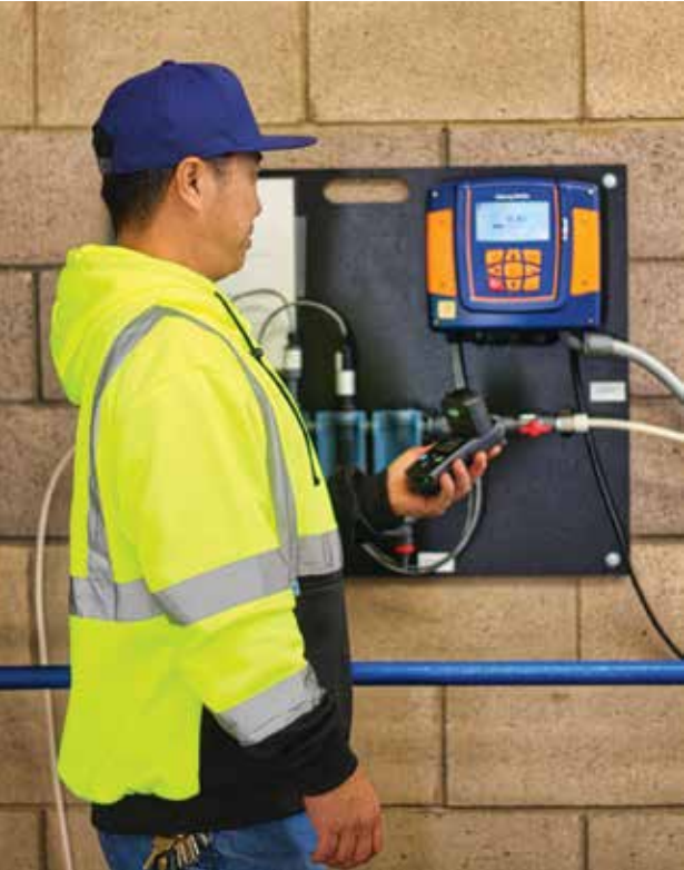
(왼쪽) MCWD 작업자가 주 배관 밸브의 정상 작동을 확인하기 위해 조작 중인 모습. (위) MCWD 작업자가 배수 시스템 내 염소 잔류량 정기 점검을 실시하는 모습.
