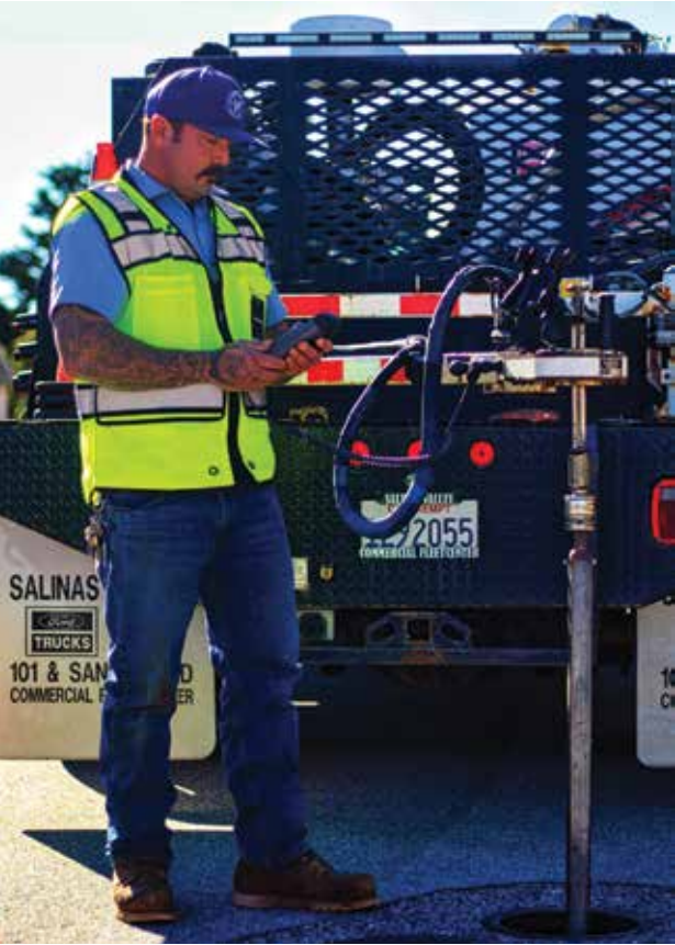
(왼쪽) MCWD 작업자가 주 배관 밸브의 정상 작동을 확인하기 위해 조작 중인 모습. (위) MCWD 작업자가 배수 시스템 내 염소 잔류량 정기 점검을 실시하는 모습.
