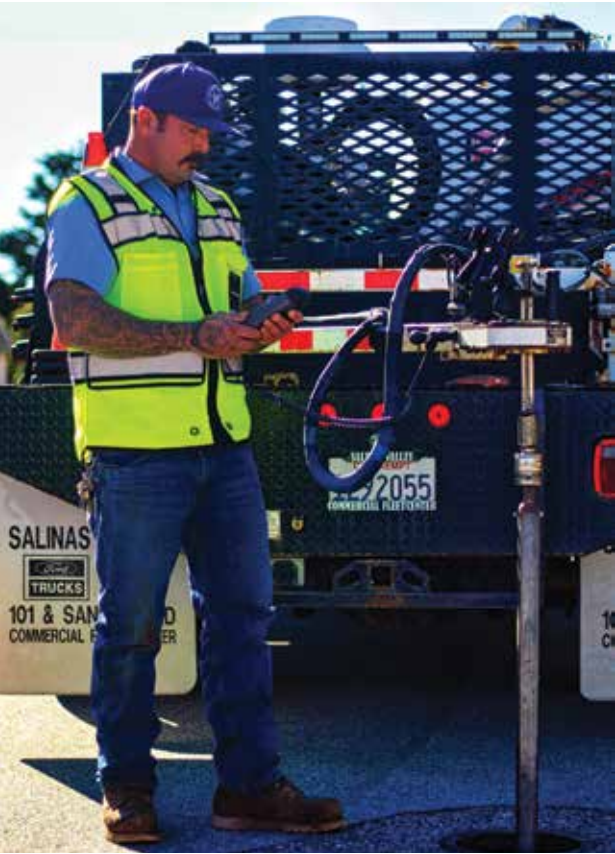
(Izquierda) Operador de MCWD ejercitando una válvula de agua principal para asegurarse de que funcione correctamente. (Arriba) Operador de MCWD realizando controles de rutina sobre residuos de cloro en el sistema de distribución.
