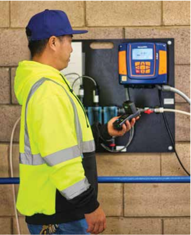
(Izquierda) Operador de MCWD ejercitando una válvula de agua principal para asegurarse de que funcione correctamente. (Arriba) Operador de MCWD realizando controles de rutina sobre residuos de cloro en el sistema de distribución.
