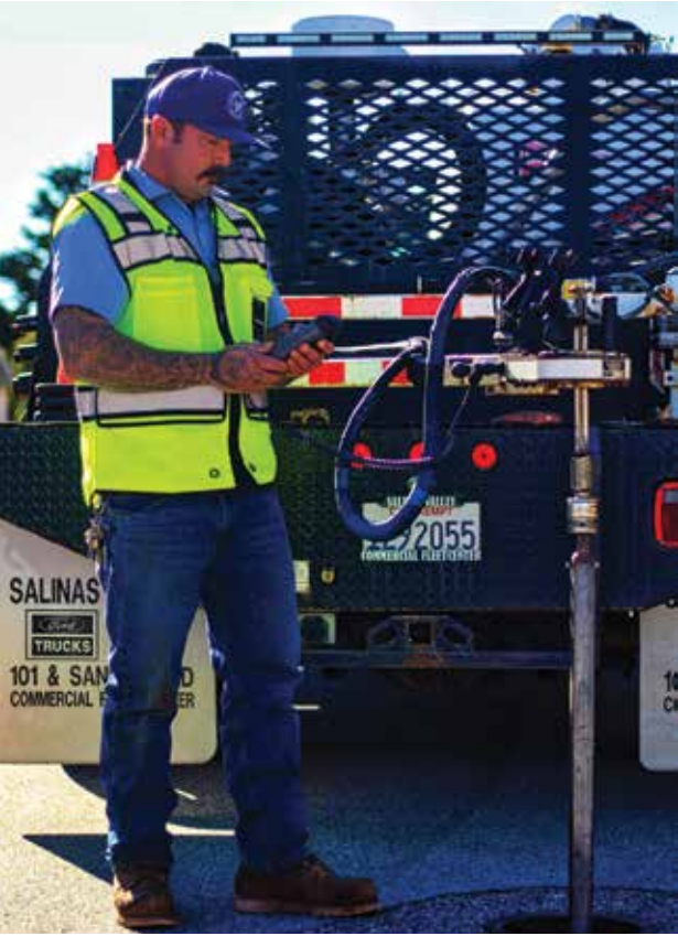
(Kaliwa) MCWD Operator na ina-ehersisyo ang pangunahing balbula ng tubig para masiguro ang tamang paggana. (Itaas) MCWD Operator na nagsasagawa ng mga rutinang pagsususri sa mga tirang chlorine sa sistema ng distribusyon.
