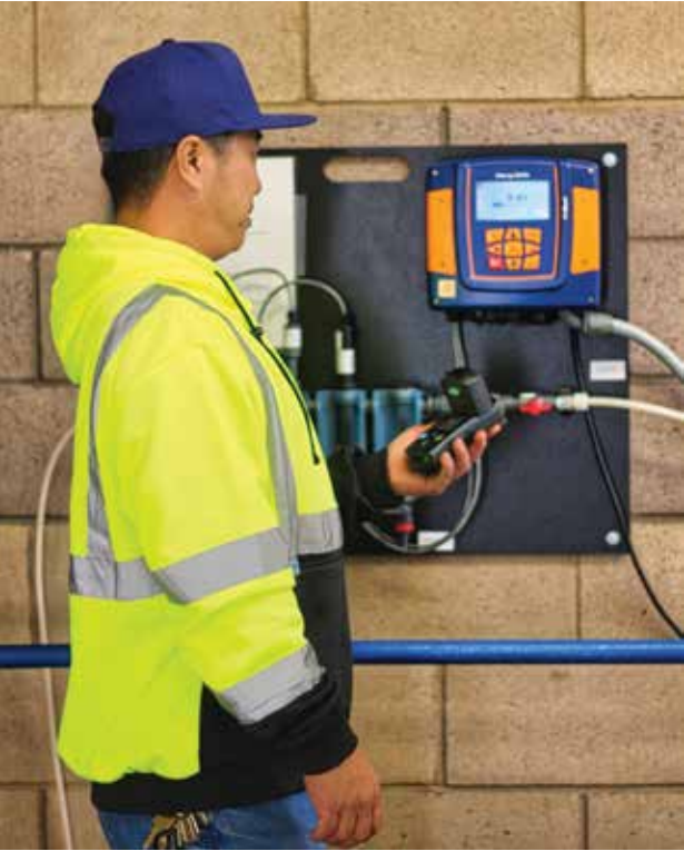
(Kaliwa) MCWD Operator na ina-ehersisyo ang pangunahing balbula ng tubig para masiguro ang tamang paggana. (Itaas) MCWD Operator na nagsasagawa ng mga rutinang pagsususri sa mga tirang chlorine sa sistema ng distribusyon.
