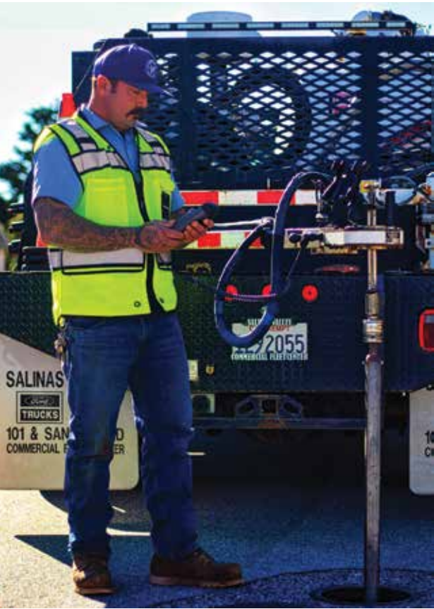
(Trái) Nhân Viên Vận Hành của MCWD đang vận hành thử van ống dẫn nước chính để đảm bảo hoạt động bình thường. (Trên) Nhân Viên Vận Hành của MCWD thực hiện kiểm tra định kỳ dư lượng clo trong hệ thống phân phối.
