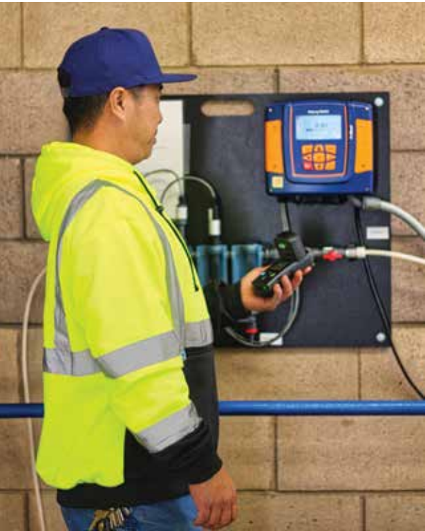
(Trái) Nhân Viên Vận Hành của MCWD đang vận hành thử van ống dẫn nước chính để đảm bảo hoạt động bình thường. (Trên) Nhân Viên Vận Hành của MCWD thực hiện kiểm tra định kỳ dư lượng clo trong hệ thống phân phối.
