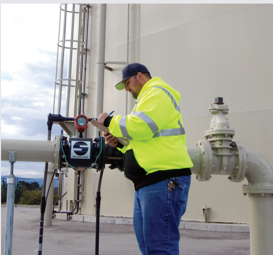
Người vận hành thực hiện kiểm tra và giám sát đồng hồ đo lưu lượng tại một trong các hồ chứa của Thủy Cục
